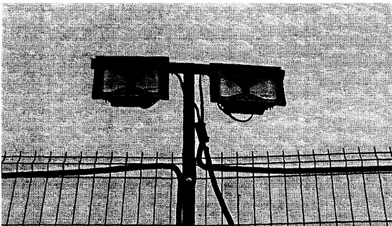
На 6 столбах ( по углам и в центре ) устанавливаются светодиодные светильники ( по 2 шт) мощностью 50 Вт каждый.
