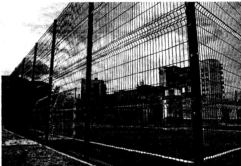
Ограждение высотой 4 м по периметру и одной калиткой изготавливается из сетки , толщина оцинкованной проволоки 4,5 мм с покрытием ПВХ зеленого цвета 11АЬ6005. Ячейка 100 x 50 мм.
